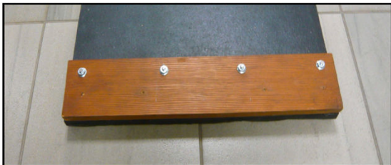
IMAGE 1-5. Installation de l'entretoise
